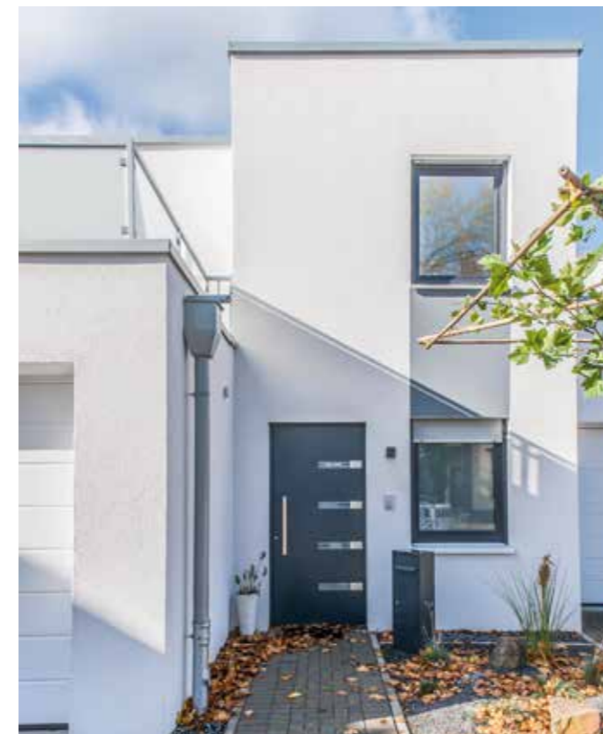
Duisburg Rahm – Unsere Reihenhäuser im Neo-Bauhausstil an der Angermunder Straße wurden als besonders sehenswerte Bauwerke für den Tag der Architektur der Landesarchitektenkammer NRW ausgewählt
